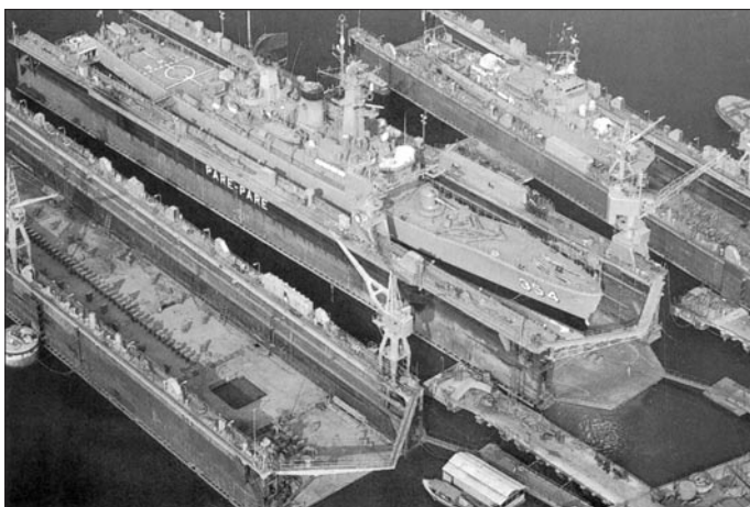
Плавающие доки компании «ПТ ПАЛ Индонизиэ» обеспечивают строительство и ремонт кораблей различных классов
